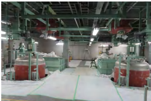
液処理室タンク保温撤去
