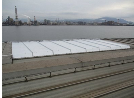
写真 2 屋根板金の補修後
