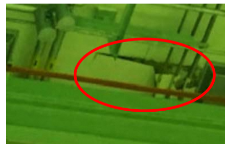
1期破碎室の天井板剥離状況(左)と補修後の状況(右)
