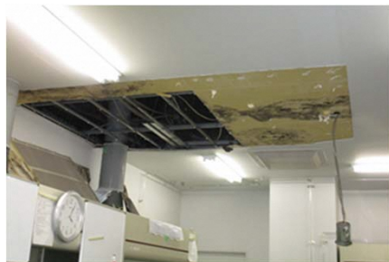
2期低濃度分析室の天井板落下状況(左)と補修後の状況
