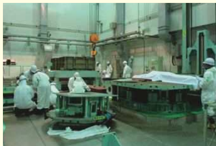
粗解体設備の解体撤去工事の様子
