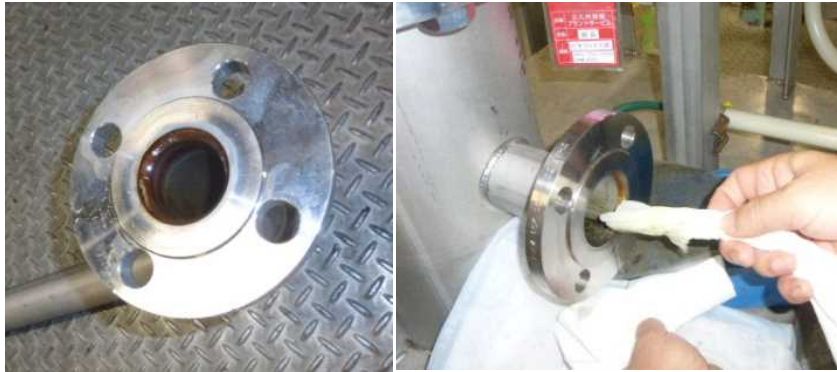
配管内部に油分が付着
