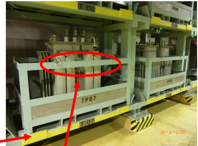
転倒防止柵設置(トランス)
