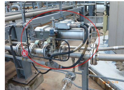
処理済油槽遮断弁
