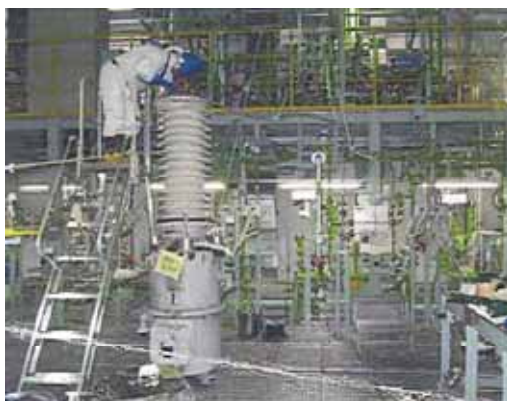
碍子の中に PCB 油が封入されたブッシング型計器用変圧器
