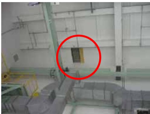
写真 天井材落下箇所 (天井を下方から撮影)
