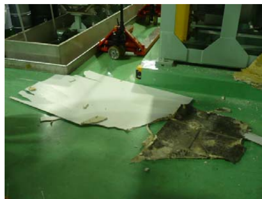
写真2 落下した天井材
