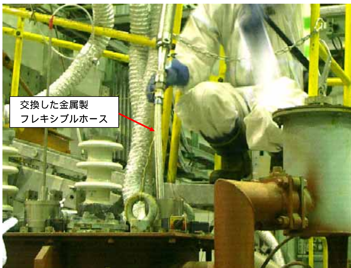
写真 2 金属製フレキシブルホース交換状況
