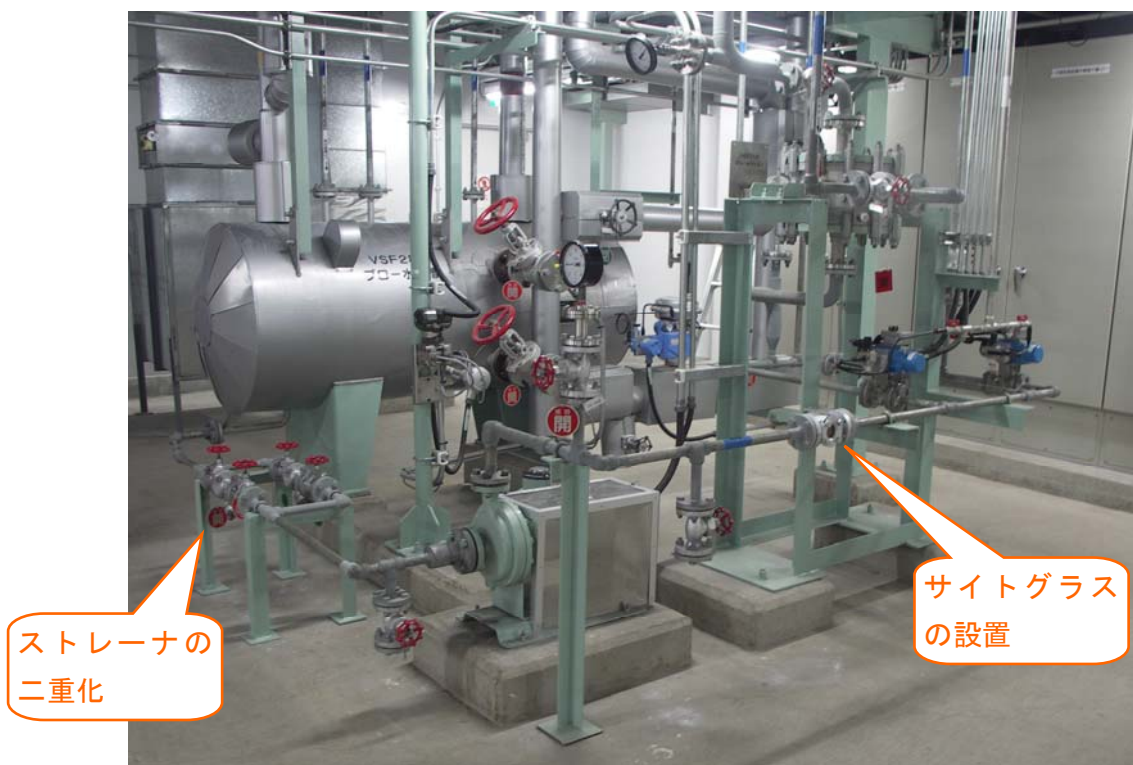
写真3 ボイラー水受槽まわり対策状況
