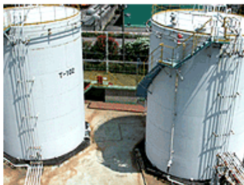
保管タンク(ホームページより) このタンクの中で、PCB を保管(現在は終了)。耐震設計を施し、高さ 2 m の防油堤で囲んでいる。
