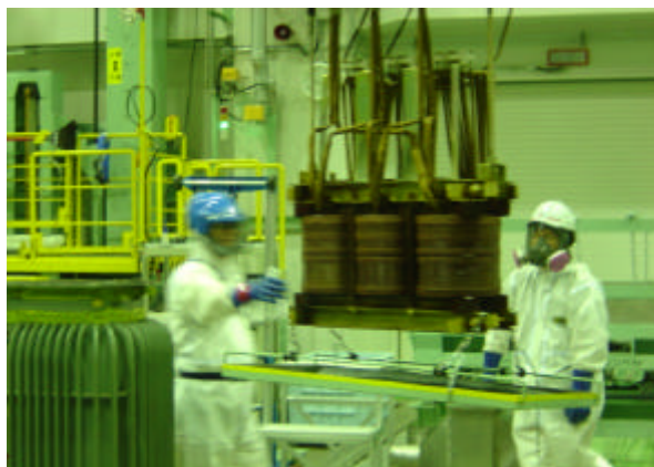
D 部材表面へのオクタデセン噴霧による高濃度PCBの析出を防止
