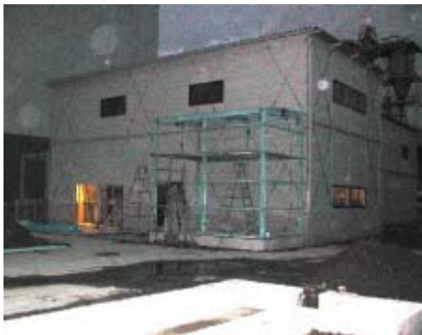
施設外観（建設工事中）
