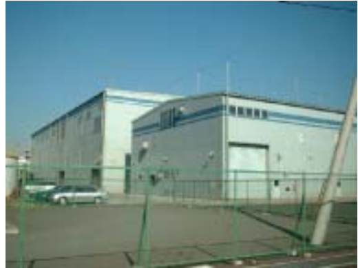
施設全景。 奥の建屋が、洗浄処理施設
