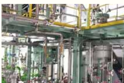
配管等除去分別前
