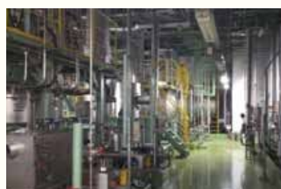
配管等除去分別前
